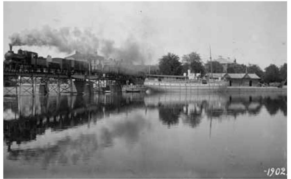
Fotograf: Didrik von Essen Linköpings hamn och järnvägsbron 1902.
